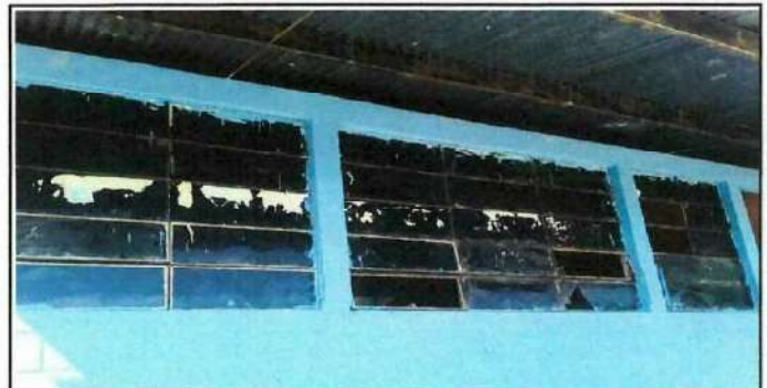
Foto 4: Se observa la necesidad de colocacion de nuevos vidrios de las ventanas
