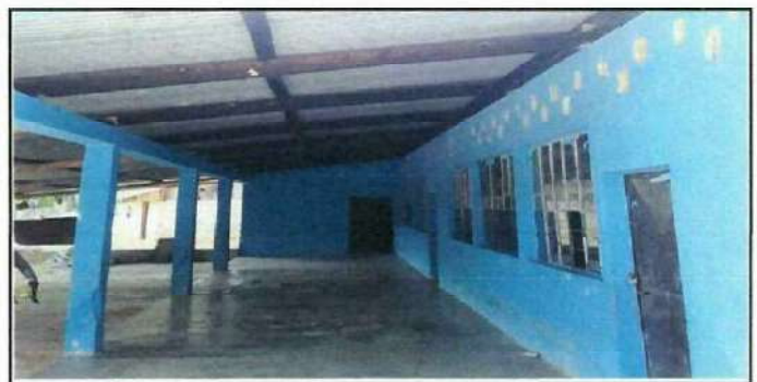
Foto 6: Se observa la necesidad de la sustitucion de estructura de soporte de madera por metal.
