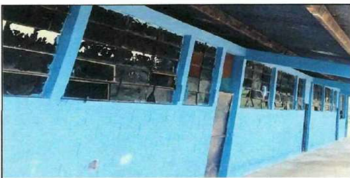
Foto 5: Se observa la necesidad de darle mantenimiento a la estructura de metal de ventana
