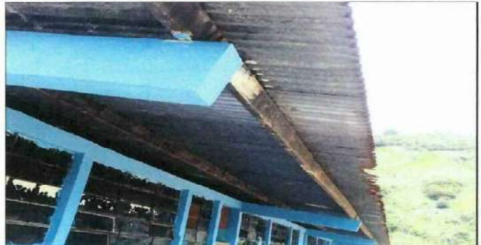
Foto 2: Se observa el deterioro de las costaneras de las aulas.
